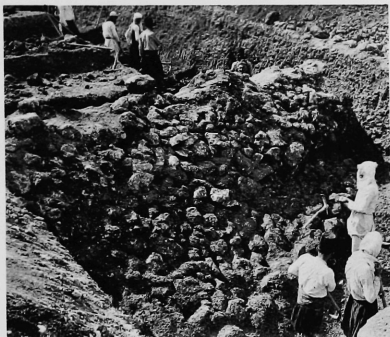
1. Le perré au pied de l'enceinte nord.
