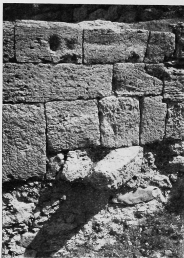
FIG. 2. — Évacuation d'eau à travers le mur d'une maison (XIV e -XIII e siècles avant J.-C.).
