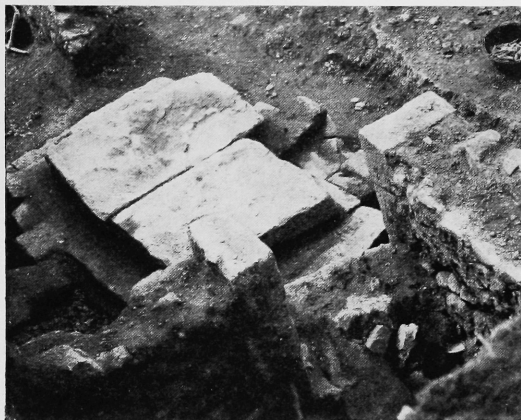
FIG. 9. — Le caveau n° XIII avant l'enlèvement des dalles de couverture. L'entrée se trouve sous le seuil de la porte avec jambages en pierres de taille au premier plan (xiv e siècle).
