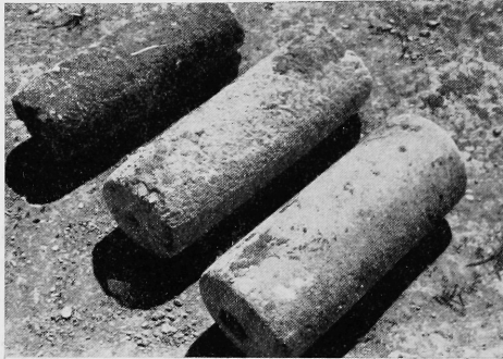
FIG. 2. — Rouleaux en pierre pour les terrasses en terre des maisons d'Ugarit. (Long. 0 m. 51 à 0 m. 60.)
