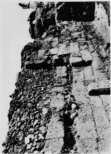
2. Détail montrant le logement de la poutre.
