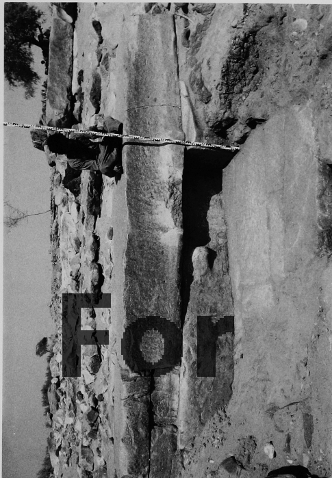
b. Anschlußpunkt an der Nordostecke des Pfeilers 1. Blick nach Norden. Rechts von der Bildmitte die Trennfuge zwischen Pfeiler und Wängemauer.
