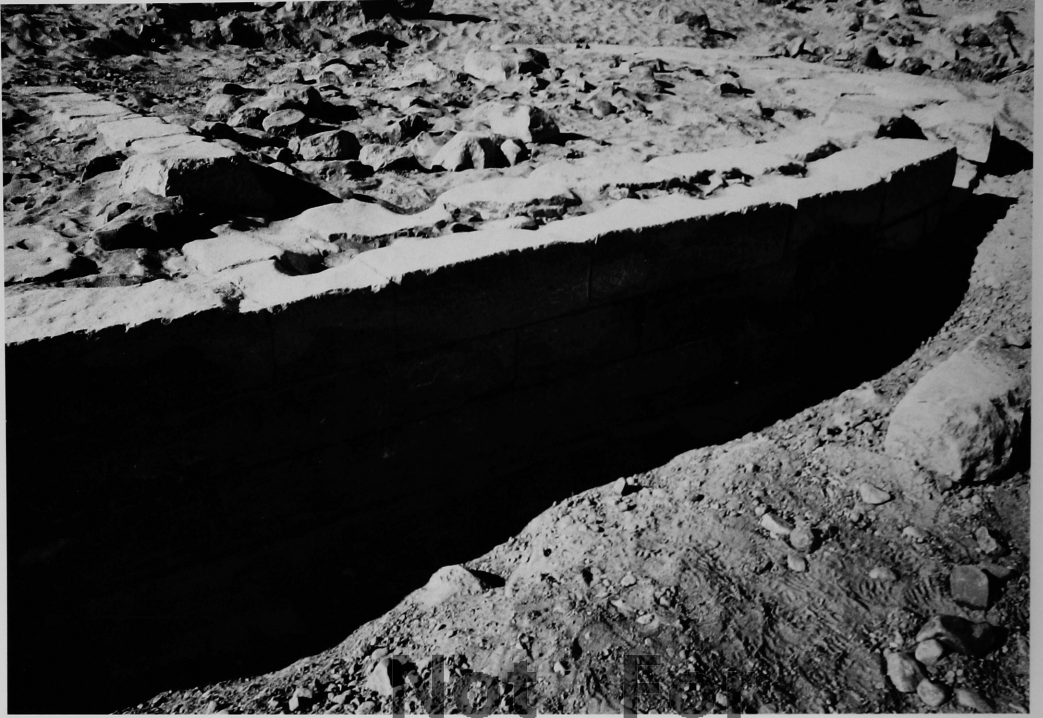
a. Nordseite des Pfeilers 3 mit Anschlußpunkt im Schattenbereich der Fußlinie.
