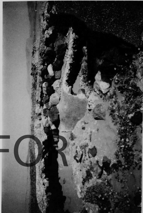
d. Detail mit verschiedenen Mauererhöhungen (Nordbau NI): Der lose geschüttete Mauerkern und die unterschiedlichen Putzqualitäten sind gut erkennbar.
