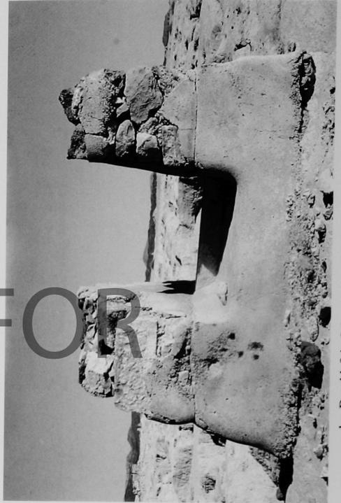
d. Durchlaß in Schüttbauweise (mit eingebundener Schwelle).
