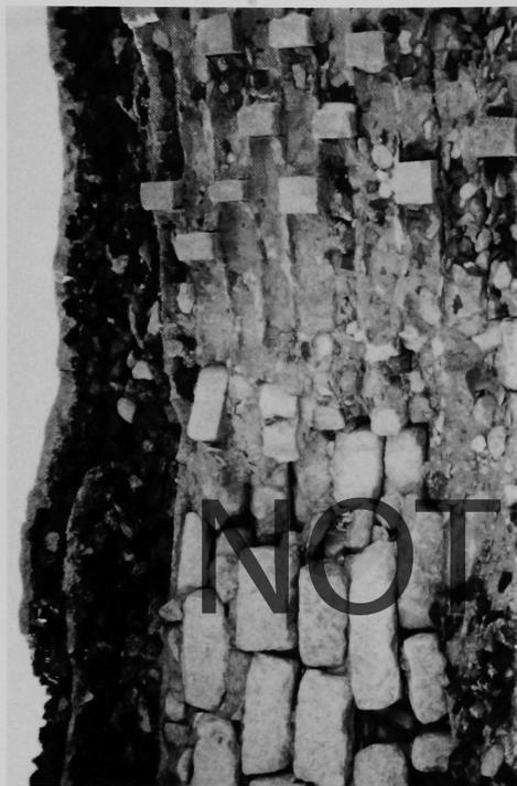
b. Beschädigter Mauerbereich (Nordbau NI): links bei doppelschalliger Wand Blick auf die Innenschale, rechts bei einfacher Außenwand Blick auf den Mauerkern.
