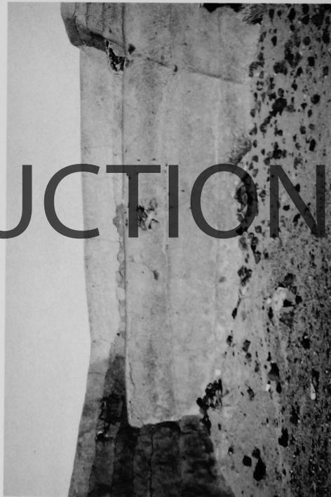
c. Mauerpartie der Anlage al-Miānā (ehemaliger Auslaß): Die oberste Schicht stellt eine Erhöhung dar, vermutlich ist auch der mittlere Teil erst nach den Mauern rechts und links errichtet worden.
