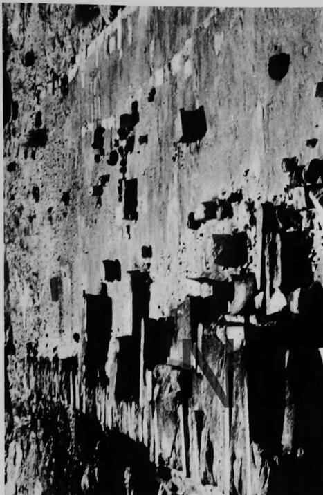
b. Nordbau N1: Oberseite der Abschlussmauer AN 1 von Osten mit Erhöhung (links) und vorgeblendeter Verstärkung (rechts).
