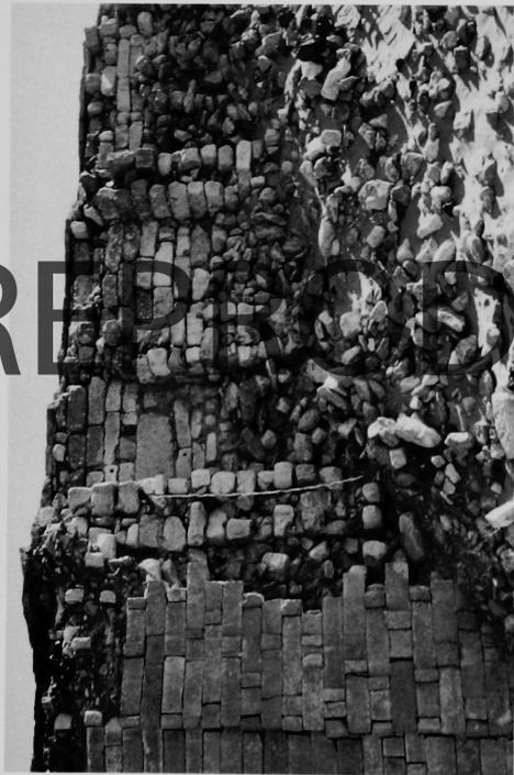
a. Beschädigter Teil des Nordbaus NI mit Blick auf kammerartige Innenstruktur.
