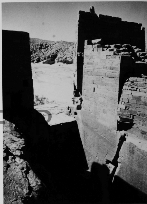
b. Felsriß im Tosbecken Südbau S 1.
