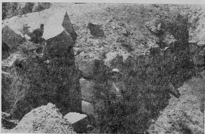
Рис. 21. Фасадная стена северного коридора.
