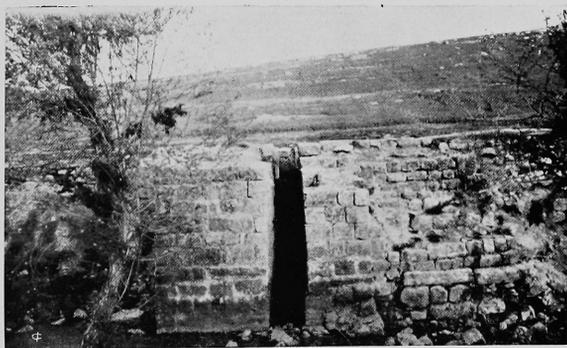
3. — Vanne de décharge des eaux du Qanâyé dans le lit du Qouwayq
